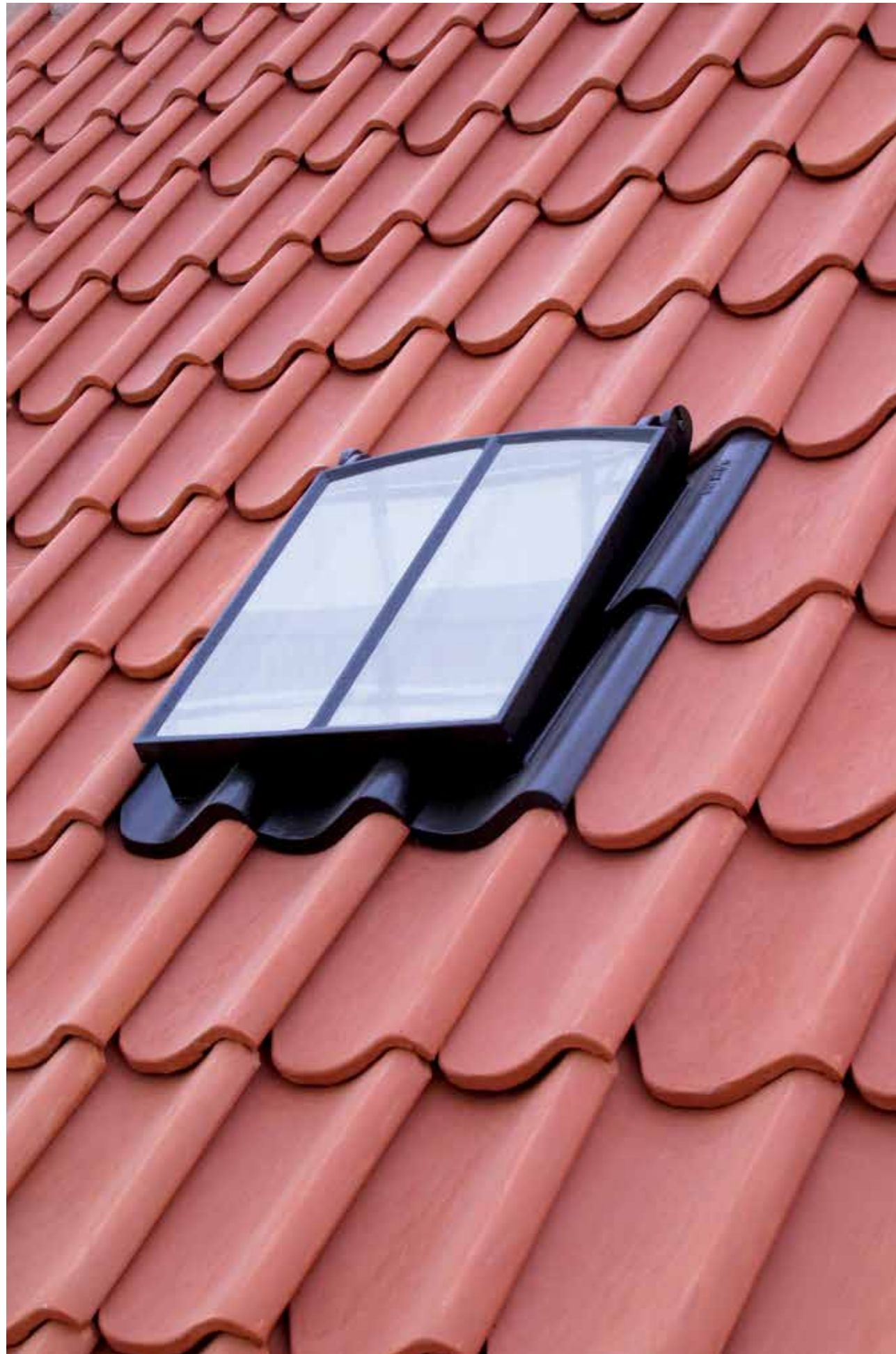
Dachfenster aus Gusseisen, 6-ziegelig, und einem senkrechten Pfosten, Dantegl, handgestrichene Flügeldachziegel JP2 von Monier. Neu verlegt im Jahr 2020 während der laufenden Renovierung von Nyboder, Kopenhagen.
