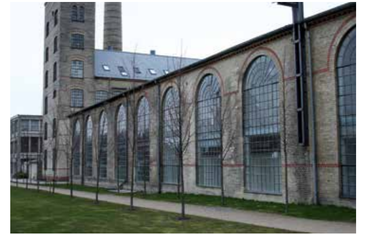
Fenster für Brede Værk in Kongens Lyngby. Die Fenster sind etwa 7 Meter hoch - ebenfalls mit einem Rundbogen mit fächerförmigen Sprossen im oberen Bereich.
