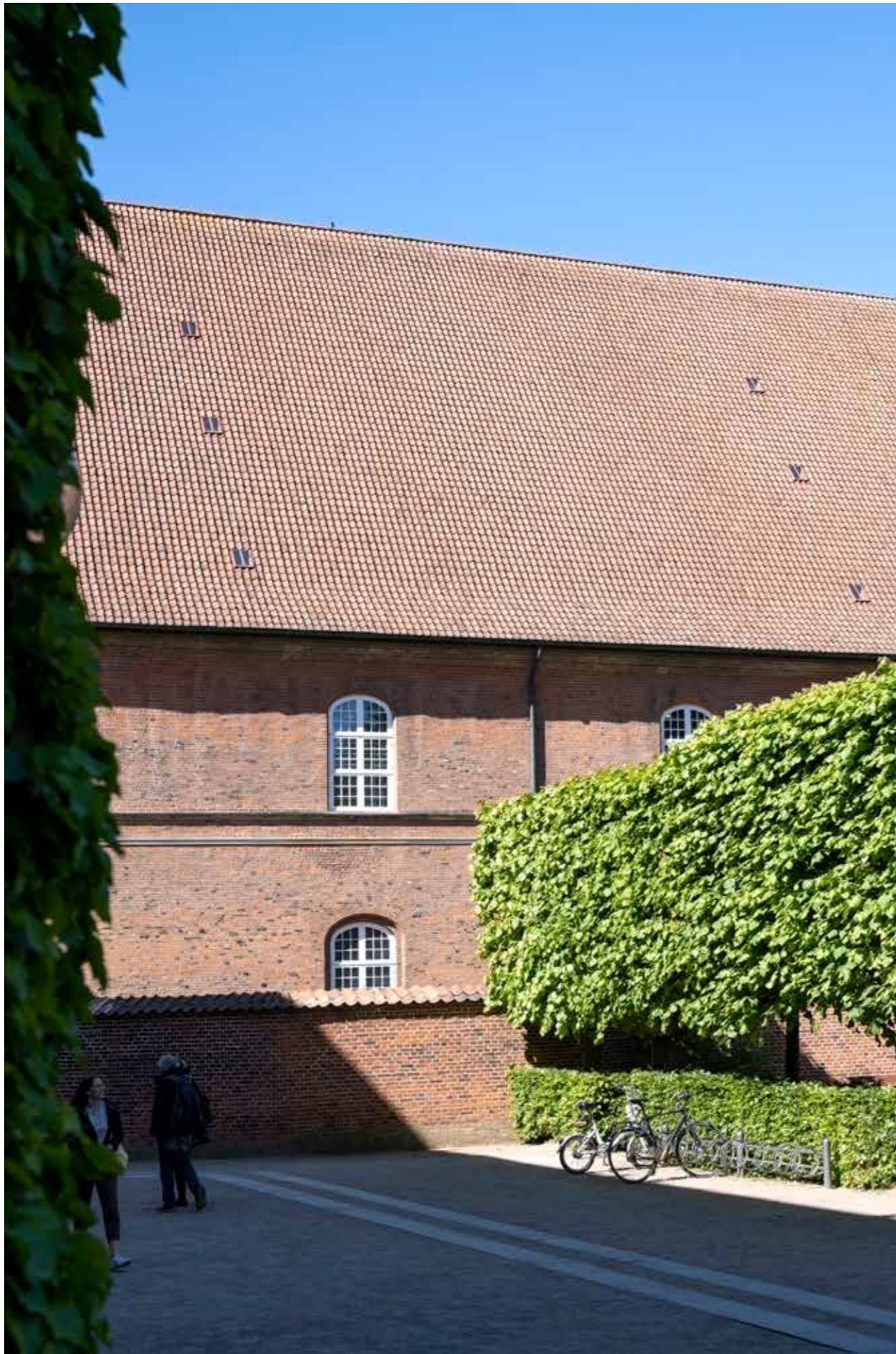
Unisolierte 9-Ziegel-Dachfenster, Dantegl, handgestrichene Flügeldachziegel von Monier im Bryghus von Christian IV, Kopenhagen.
