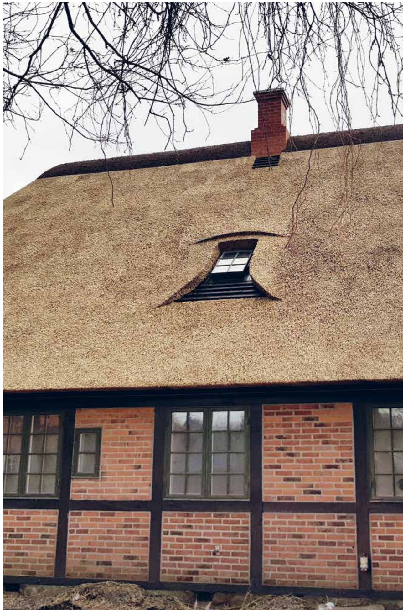
6-Ziegel-Dachfenster mit flachem Rahmen. Von Ruud Conjin gedecktes Reetdach.
