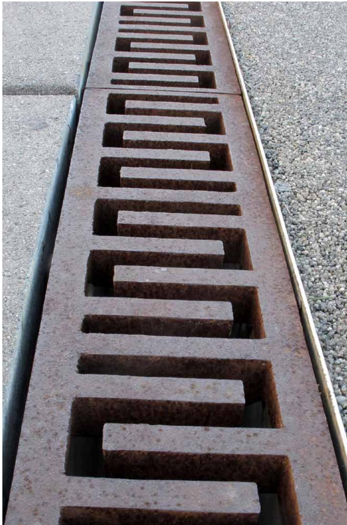
Der Stahlrahmen ist zum Einasphaltieren bestimmt Er besteht aus rostfreiem Stahl und hat einen zusätzlichen Rand, der um den Gitterrost fasst, so dass der Asphalt direkt bis zu ihm verlegt werden kann. So liegt der Rost frei und kann abgenommen werden, ohne den Asphalt zu beschädigen.
