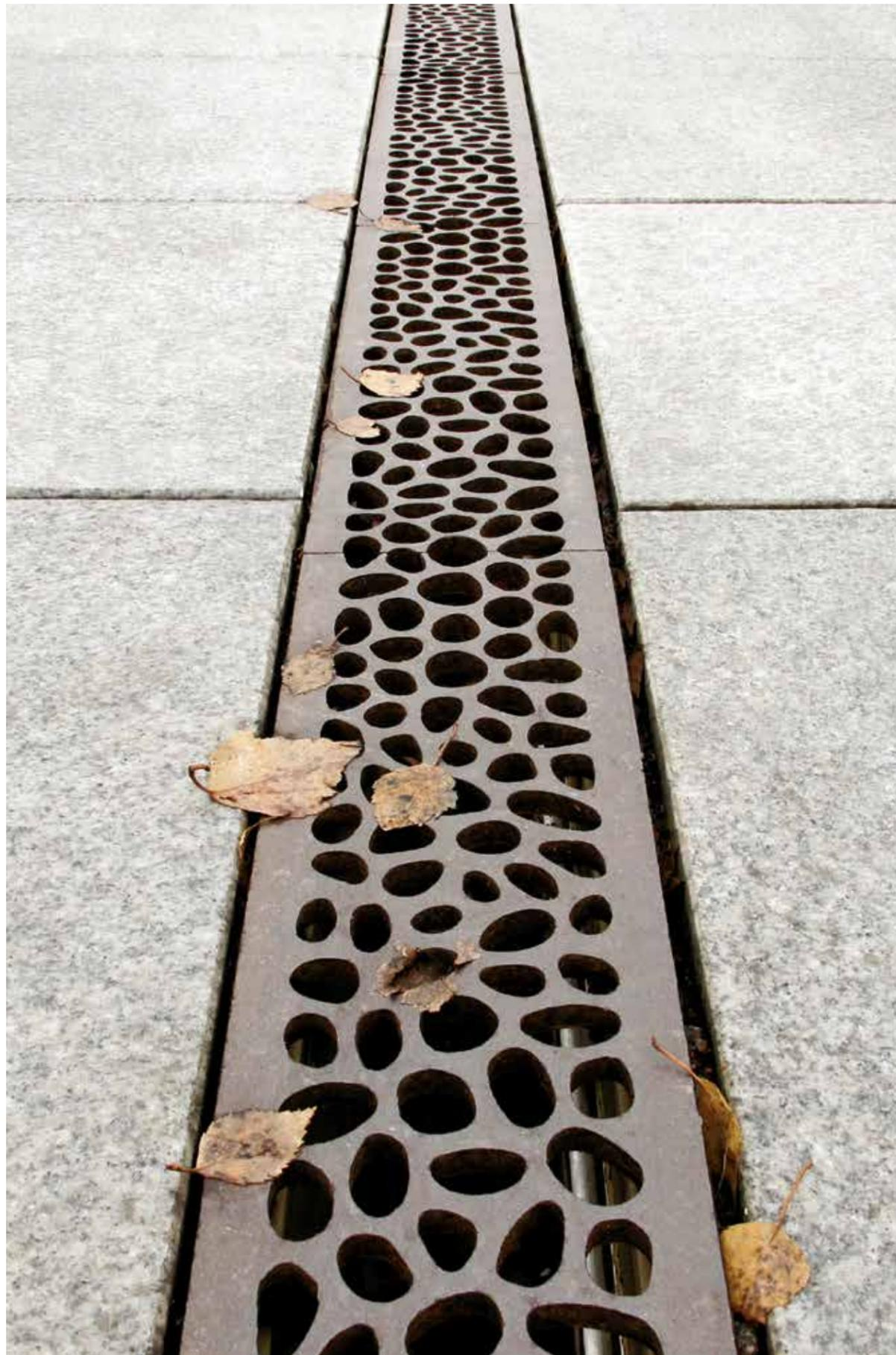
Das Muster des Water Cell Linientwässerungsrustes wird in einer Belagplatte mit dem gleichen Format wiederholt. Dadurch entsteht im Boden eine Wechselwirkung zwischen den Gittern, die das Wasser durchlassen, und den Fliesen, die eine geschlossene Oberfläche bilden.
