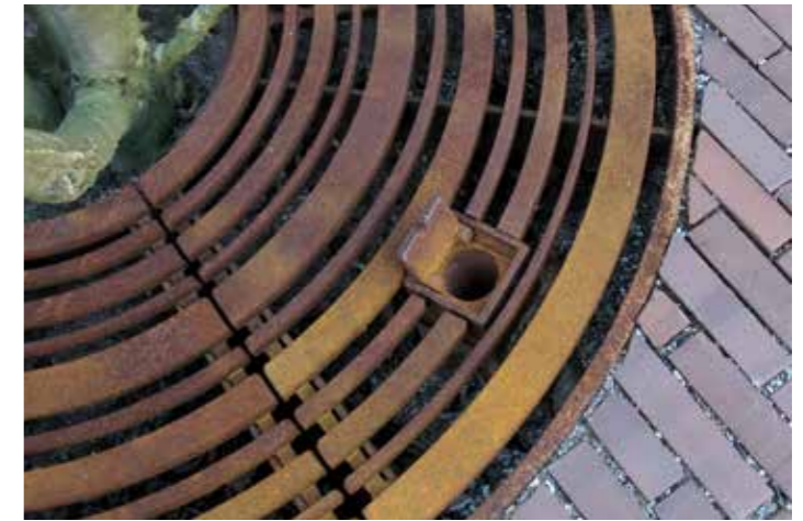
Die Baumscheibenroste sind mit Scheinwerfern von Iquzzini ausgestattet.
